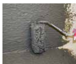
Aplikace: štětcem, hladítkem nebo válečkem
