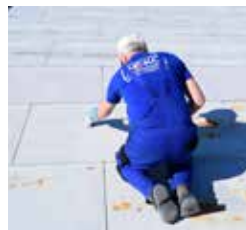
Ošetřená plocha po aplikaci antikoroziního nátěru
