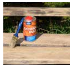
Natřete lazourov nebo ochranným olejem
