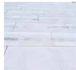
Schnutí antikoroziního nátěru cca 4–5 hodin
