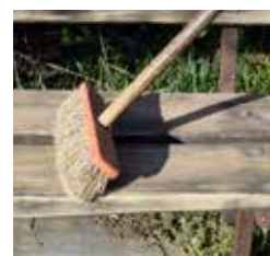
Povrch mechanicky očistěte
