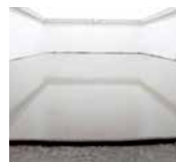
Nechte povrch vytvrdnout. Pochůzný je po cca 4-6 hodinách
