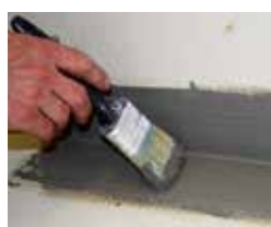
Aplikace: štětcem, hladítkem nebo válečkem
