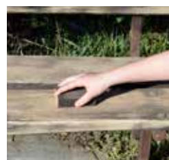
Odstraňte zbytky starého nátěru
